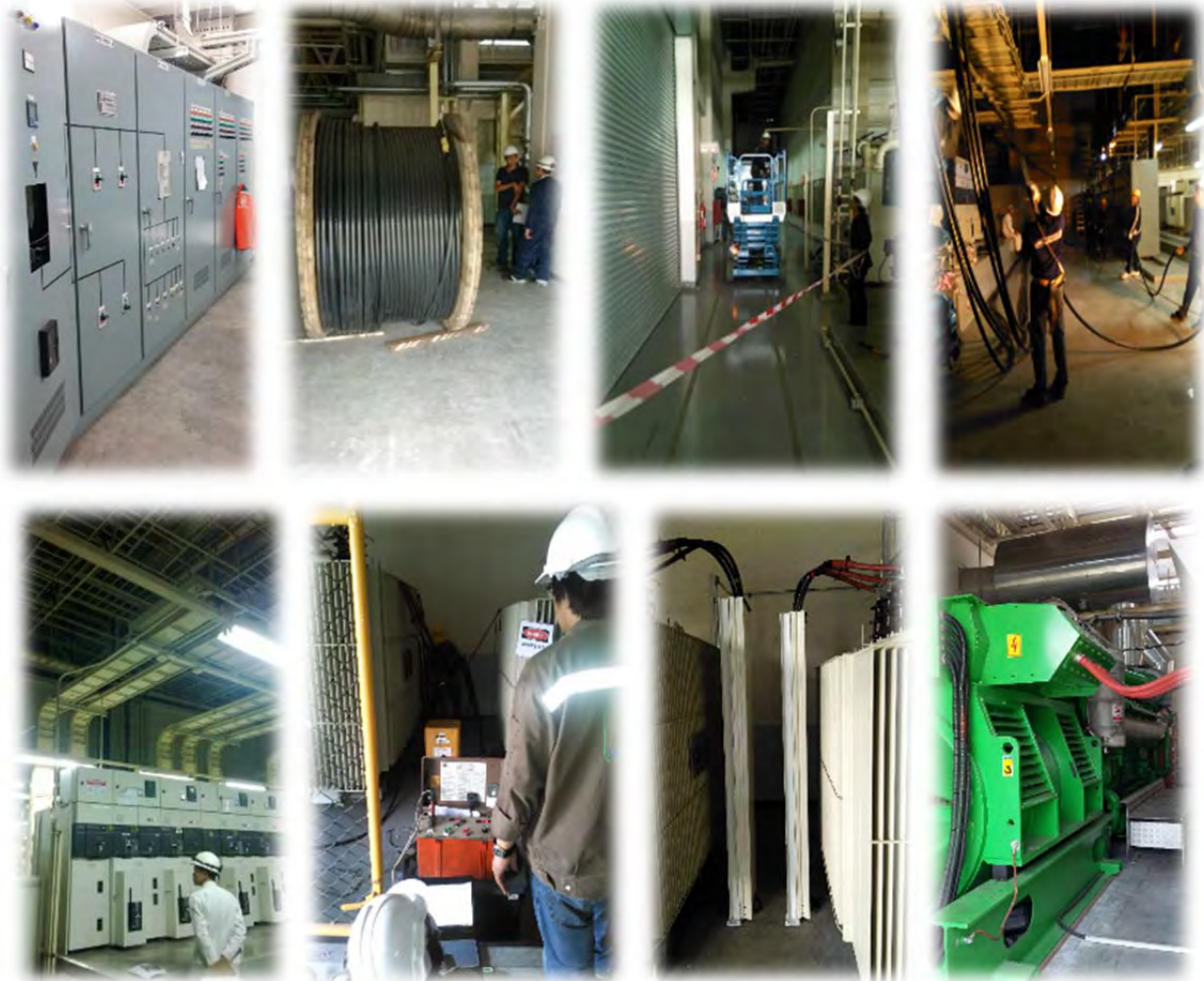
ติดตั้งระบบ ทดสอบและเชื่อมต่อ ระบบ MV System ( 22 kV )
