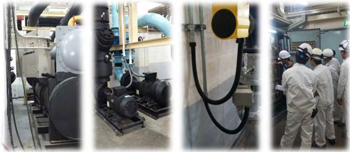
ติดตั้งสายส่งกำลังไฟฟ้า ระบบ LV System, Control & Instrument and Training
