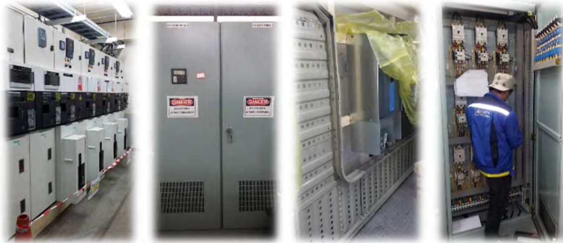
ออกแบบ ติดตั้งตู้ MDB, MCC Panel ติดตั้งสายส่งระบบ MV 22 kV
